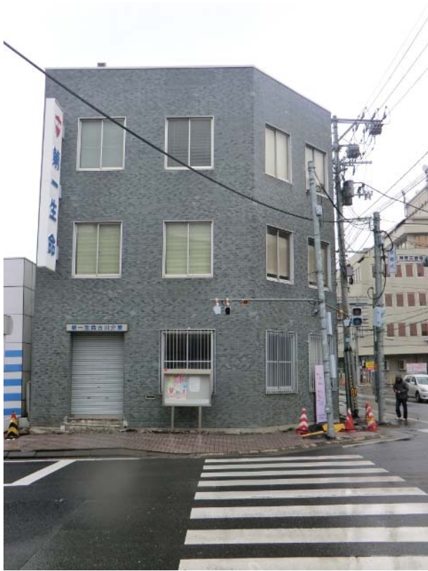
液状化による建物の傾斜
