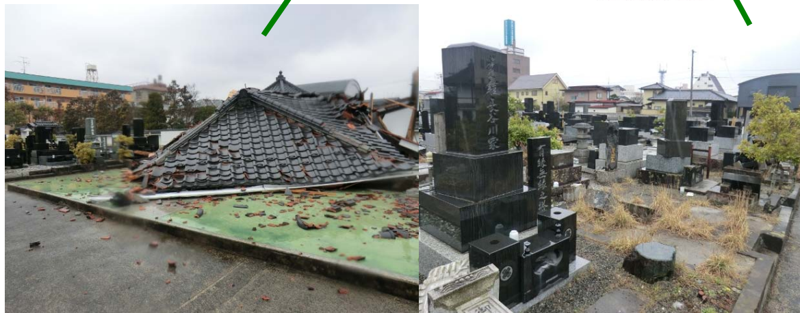
東屋が崩壊／墓石の転倒多い？
