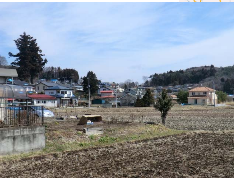
瓦の被害が比較的多いような印象
