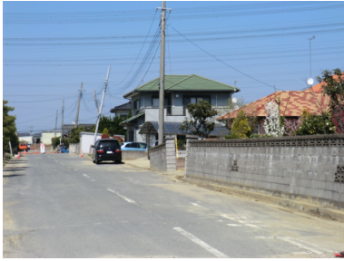
図 26 神栖市掘割川周辺の液状化による被害
