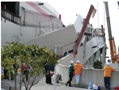
図 29 東京都町田市のスーパーマーケットの立体駐車場の進入路の崩壊
